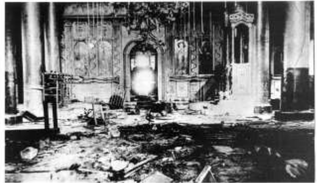
Μία άλλη άποψη της εκκλησίας στην Δελιράτσε που έχει καταστραφεί από τους βομβαρδισμούς. Another view of the nave with the shattered chandeliers seen.
