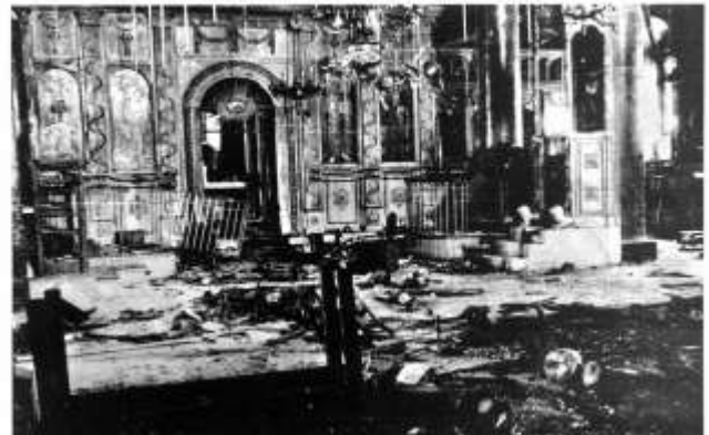
Το εσωτερικό του ναού με τις καταστραφέντες κολώνες, τα σπασμένα και τους σπασμένους. The center of the church with the destroyed towers, holy items, and chandeliers.
