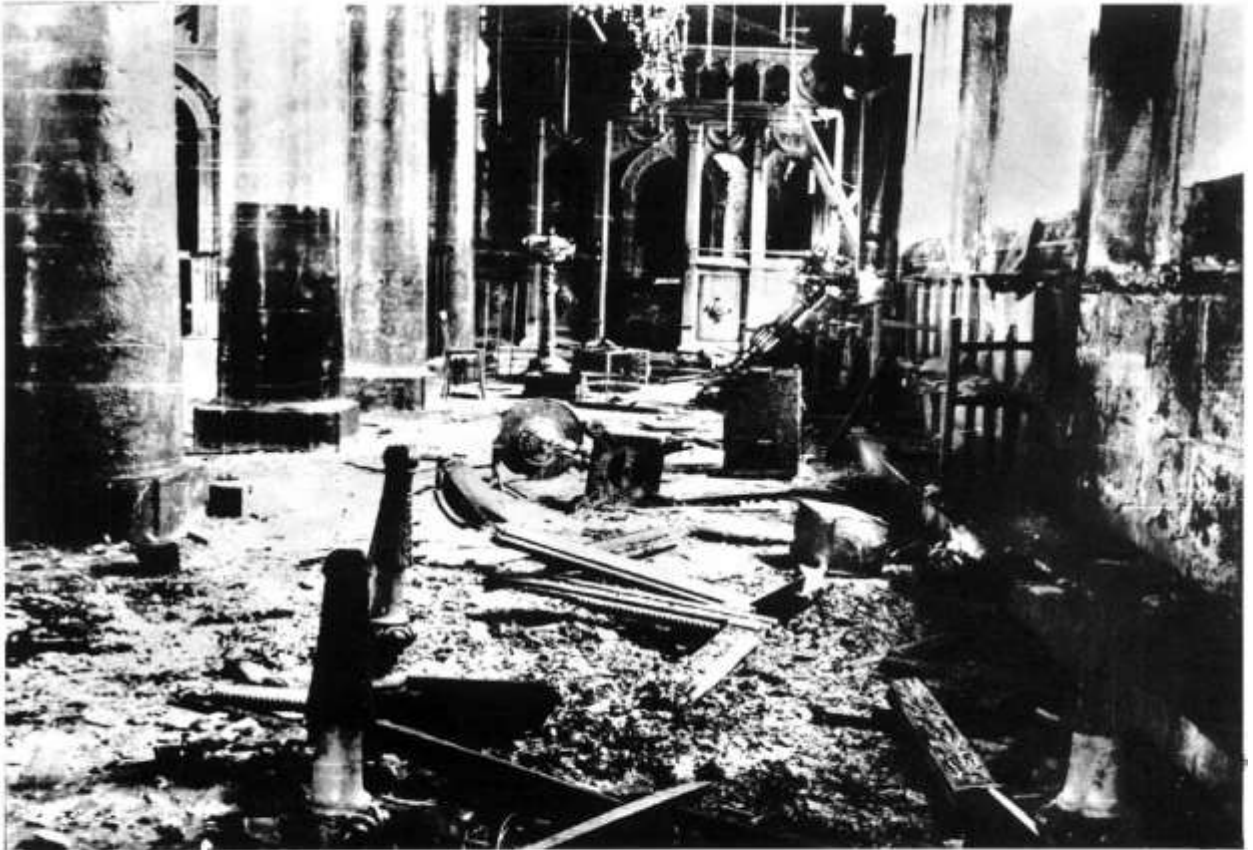
Το δεξιό κλίτος του ναού της Ι. Μονής Ζωοδόχου Πηγής γεμάτο συντρίμια.
